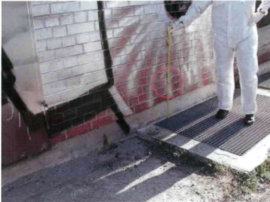
Übersichtsaufnahme Fundstelle der Abprallmarke am Stromverteilergebäude.
