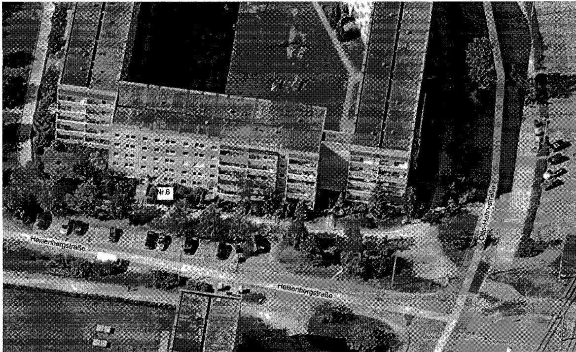
(Abbildung: Übersichtsdarstellung der „Heisenbergstraße 6 in 08066 Zwickau“.
