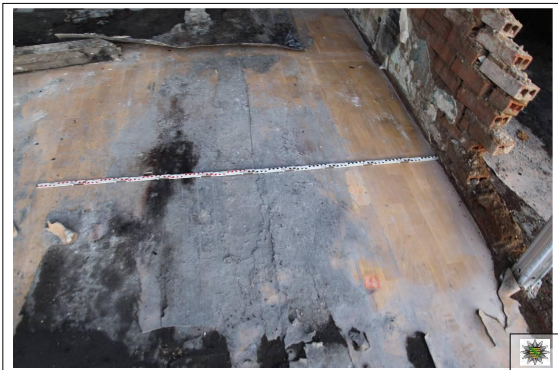
Detailaufnahme des Fußbodenbelages in der Mitte des Brandbereiches M / Lager. Deutlich ist in einer Entfernung von 1,50 m eine lokale Einbrennung im Fußbodenbelag zu verzeichnen.
