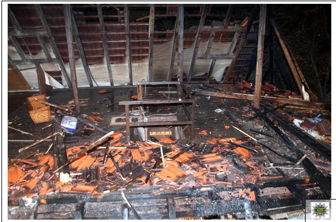
Bilder 722 und 723 Detailaufnahmen der Dachkonstruktion nach dem Entfernen der einzelnen Dachsparren durch den Bagger.
