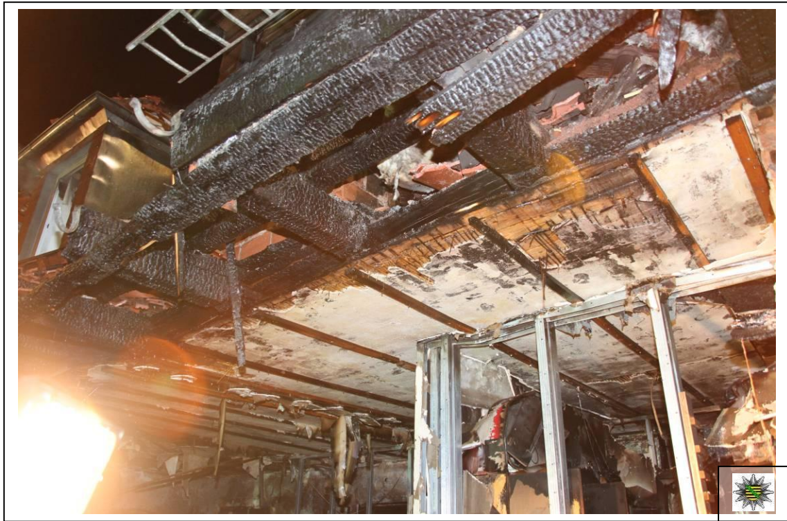
Detailaufnahme des Brandbereiches M.
