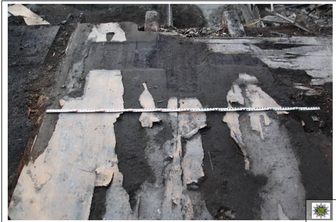
Detailaufnahmen des vorderen Bereiches vom Lager M. deutlich sind die Brandeinwirkungen auf den Fußbodenbelag zu erkennen.
