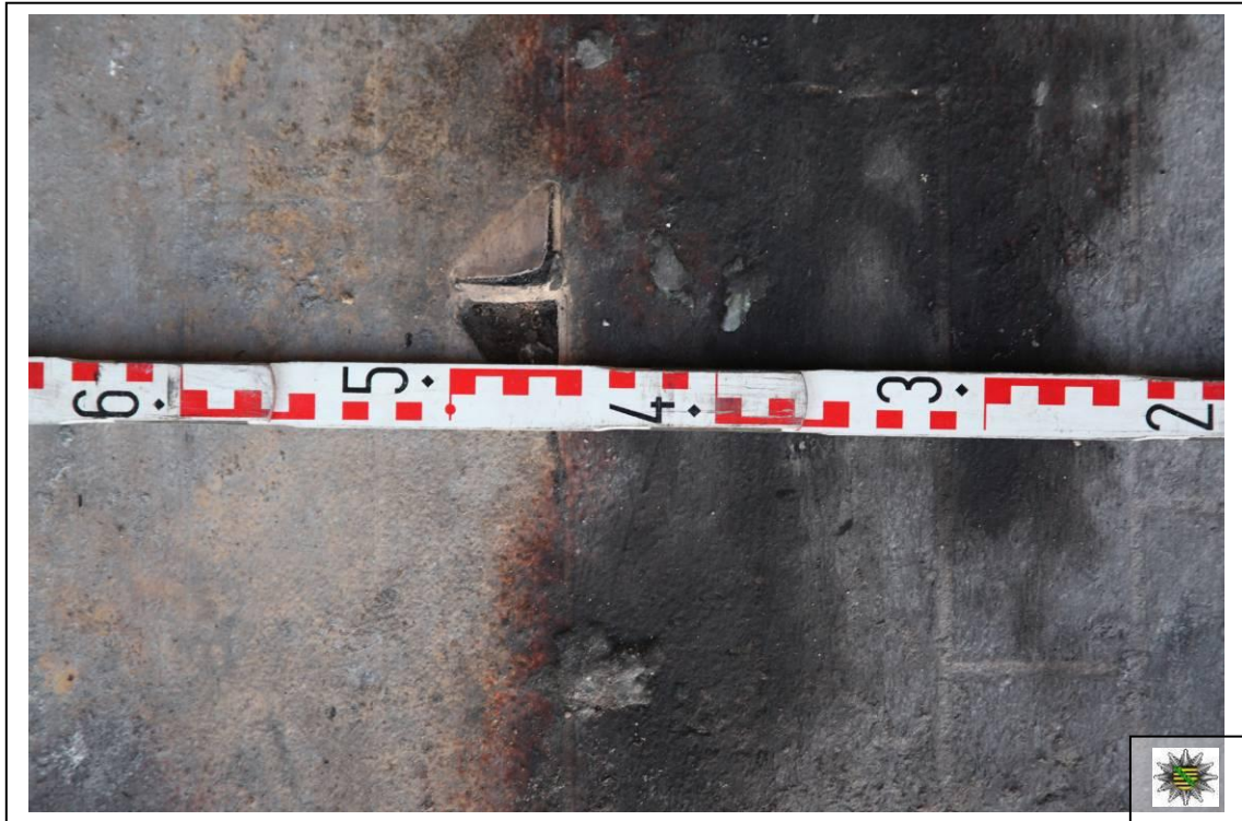
Detailaufnahme der Einbrennung sowie der Montage der Zwischenwand zwischen dem Brandbereich Lager / M und Brandbereich F.
