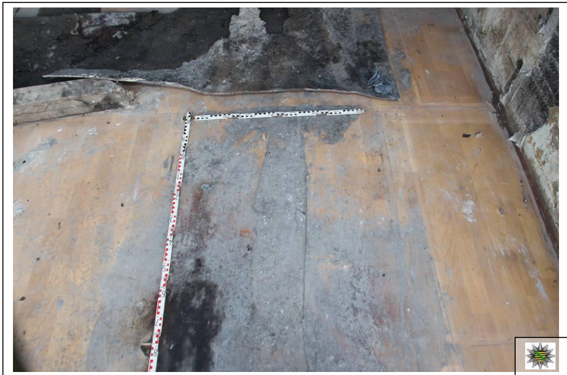
Detailaufnahme der ursprünglich Standort der Trennwand im Bereich Lager.
