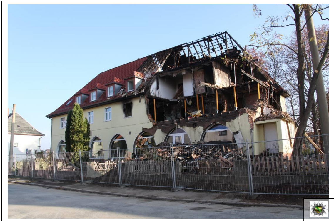
Übersichtsaufnahme des Brandobjektes von der Frühlingsstraße aus. Deutlich ist der Brandschutt unmittelbar hinter der Absperrung zu erkennen.
