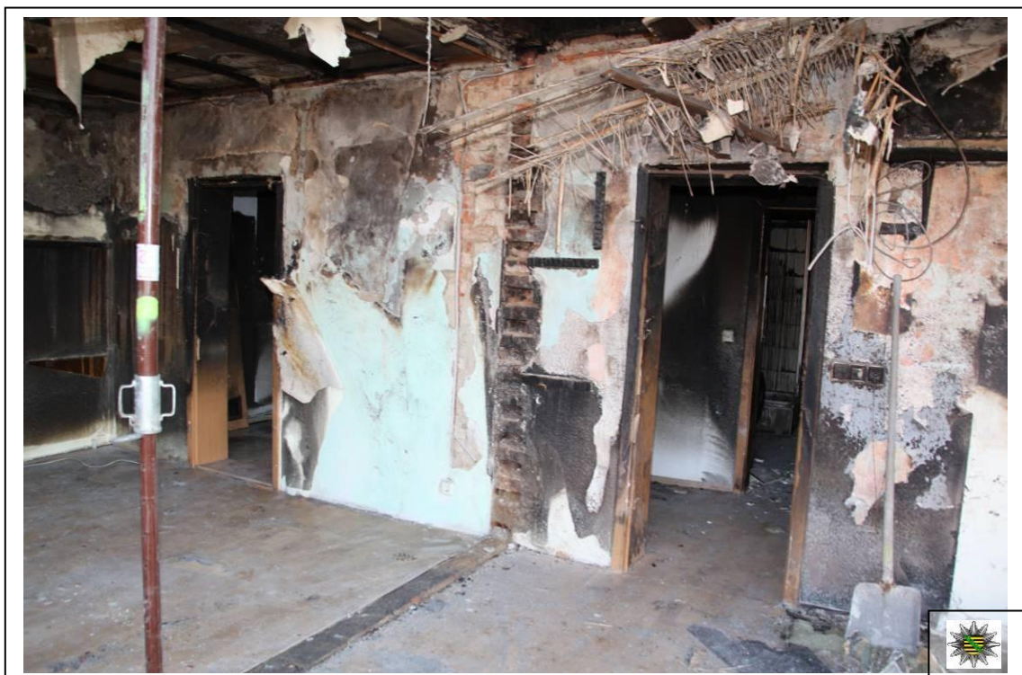
Detailaufnahme der beiden Türen, die in die hintere Brandbereiche führen. Im linken Teil des Bildes ist die Tür zwischen Brandbereich E in Richtung Brandbereich D zu erkennen. Im rechten Teil des Bildes befindet sich die Tür zwischen Brandbereich L in Richtung Brandbereich B. Die Zwischenwand, die sich zwischen dem Brandbereich F und E befand, wurde durch die Druckwelle vollständig zerstört.
