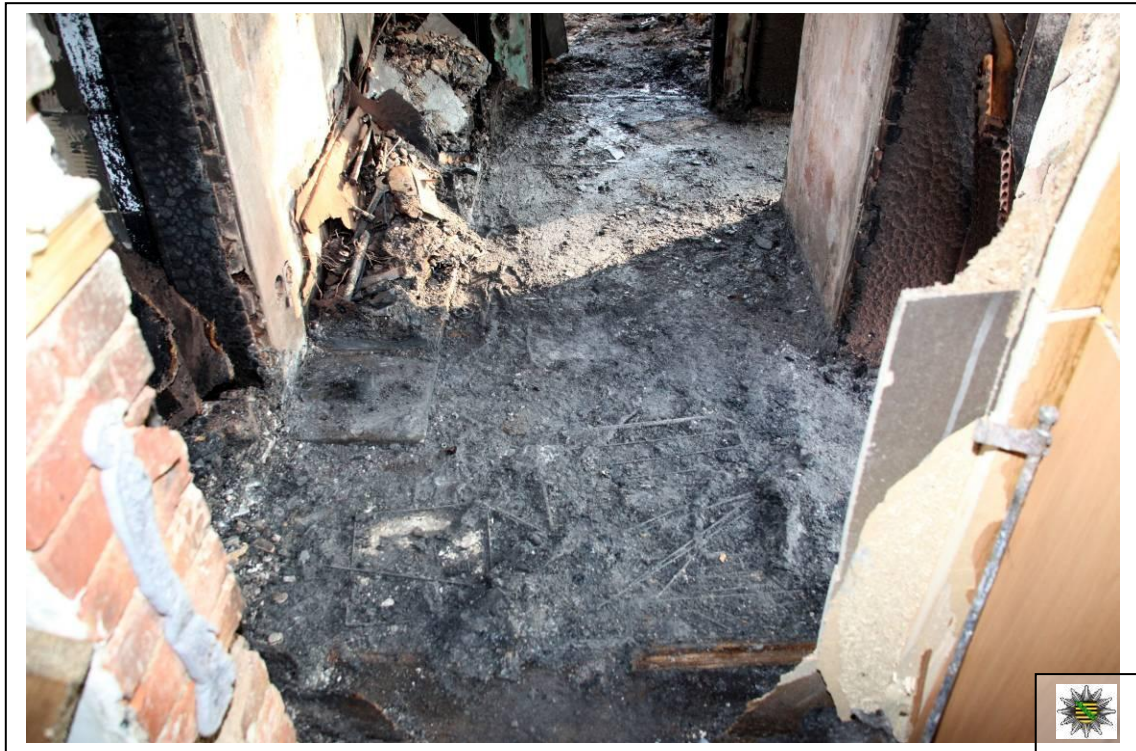
Bilder 518 und 519 Detailaufnahme des rechten Bereiches vom Brandbereich G nach der Brandschuttberäumung aus dem Fußbodenbereich. Deutlich sind die Reste des Unterschranks zu erkennen.
