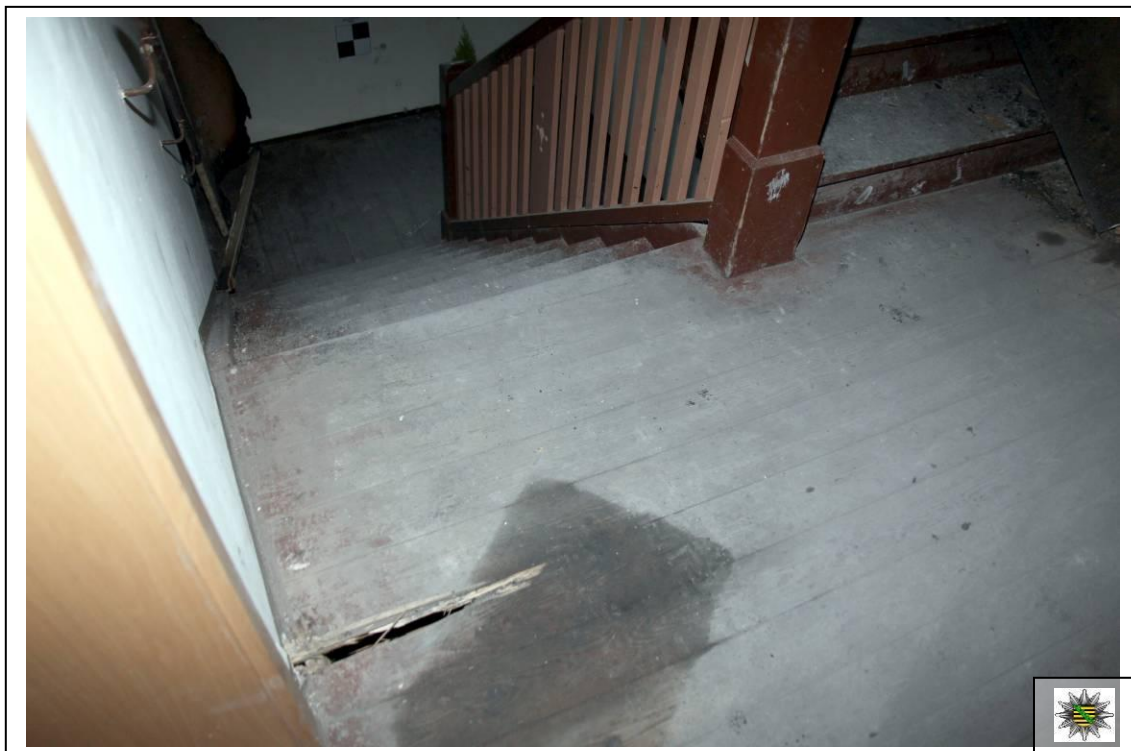
Zeigt in Richtung Zwischenpodest zwischen Erdgeschoss und Obergeschoss. Am Treppenlauf sowie an dem Geländer sind keine thermischen Beaufschlagungen durch den Brand zu erkennen.
