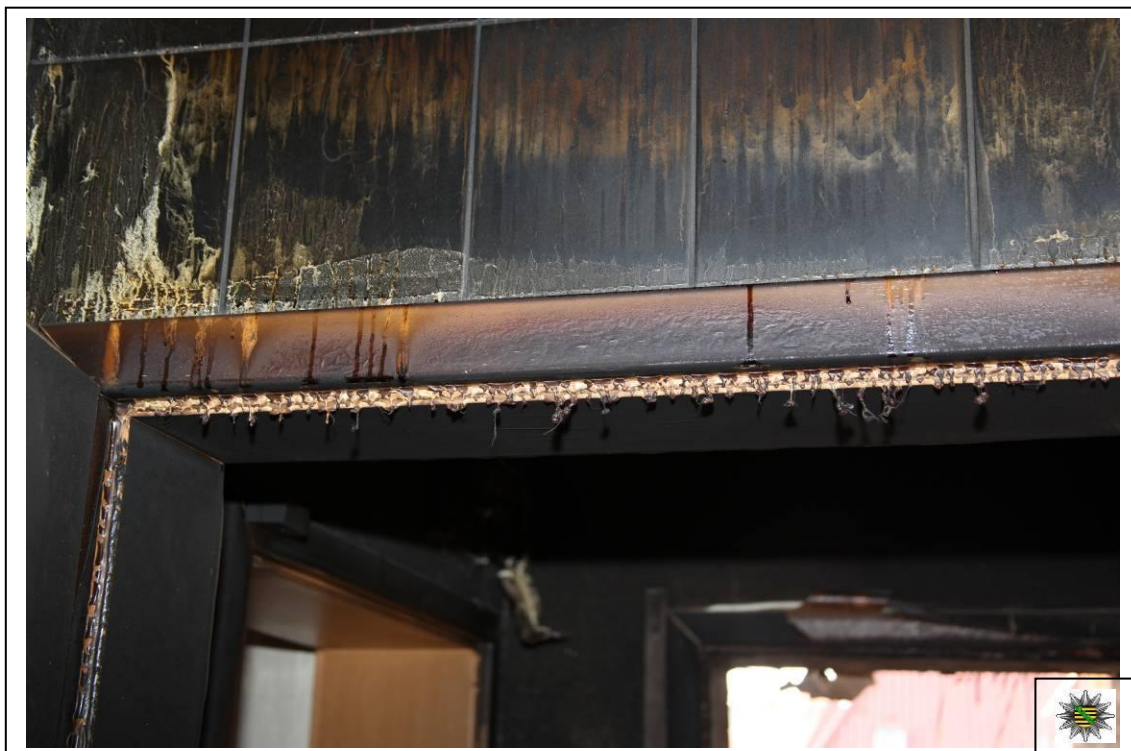
Bilder 339 und 340 Zeigten den oberen Falz der Badtür. Entsprechend der Brandeinwirkungen und markanten Merkmale muss davon ausgegangen werden, dass zum Zeitpunkt der Brandausbreitung diese Badtür geschlossen gewesen ist.
